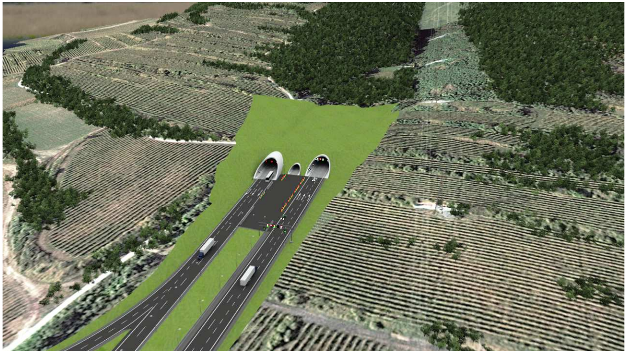
Obr.2. Východný Račiansky portál tunela Karpaty (Ing.arch. K. Hoffmann)
