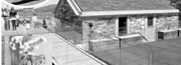
Moderne adaptovaná stará kamenná stavba na prezentačné centrum geológie pri odkryve nodulárných granitov Pedras Parideiras v Arouca Global Geopark v osade Castanheira. Strecha aj dlažba vyhlídkovej terasy nad geologickým odkryvom sú z čiernej bridlice
