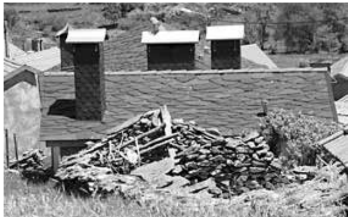
Väčší detail modernej strechy a obloženia komínov z čiernej bridlice. Castanheira, Serra da Freita
