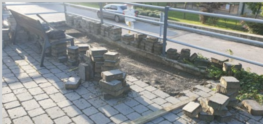
Oprava dlažby na autobusovej zastávke poškodennej vplyvom počasia
